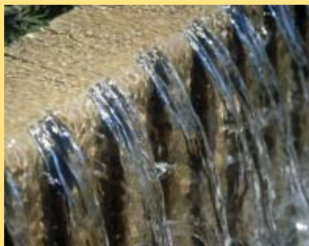
8. VANDTUNGE. En flad vandstråle der danner en hinde af vand. Når vandet under påvirkning af tryk- og tyngdekraften en vis inert, løsrives 'vandborden' fra vandhinden, og vandpladen samler sig til en turbulent stråle. Skildpaddefontænen, Rom.
